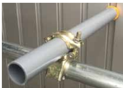
写-2 クランプ(直交)固定状況
