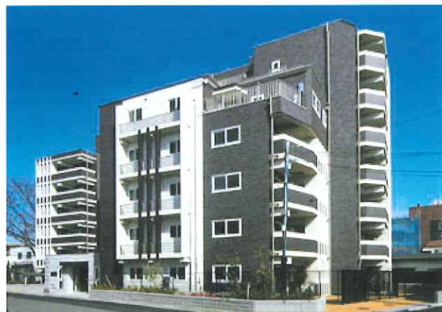
外断熱 マンション外壁(打込・開口部)
