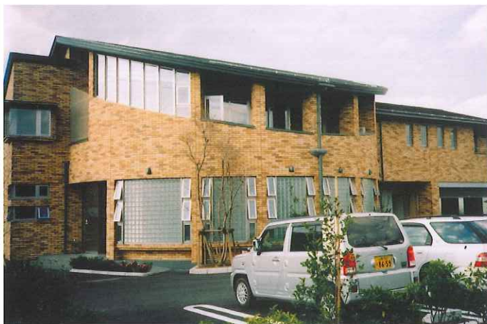
外断熱 タルボセル壁面打込み表面タイル貼 (設計:ガン建築デザイン 施工:小俣建設(株))
