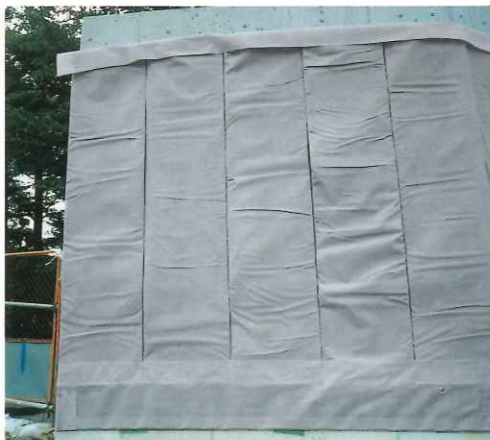
グリ・シートKPタイプを擁壁に張付けて3時間の養生後、なるべく早く裏込め土を埋め戻してください。
