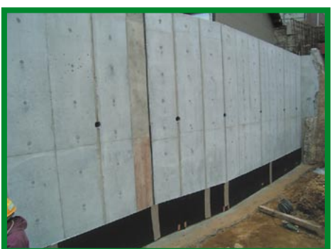
⑦ よこ貼りカルドレーンの固定
