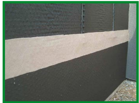
⑪ 接続部用不織布貼付け
