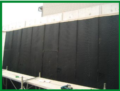
⑩ たて貼りカルドレーン上部の不織布貼付け 2
