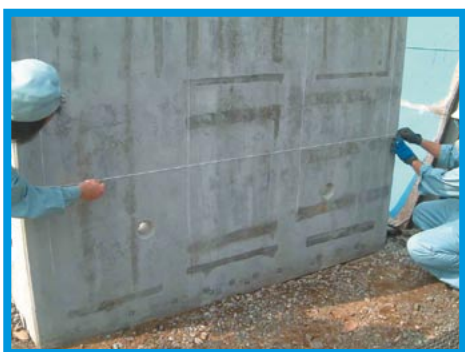
④ 墨出し（水抜き穴がある場合は、水抜き穴の位置・大きさを控えておいて下さい）
