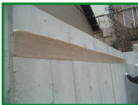
⑧ たて貼りカルドレーン上部の不織布貼付け 1
