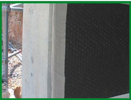
⑩ たて貼りカルドレーン端部切断部の不織布貼付け 2
