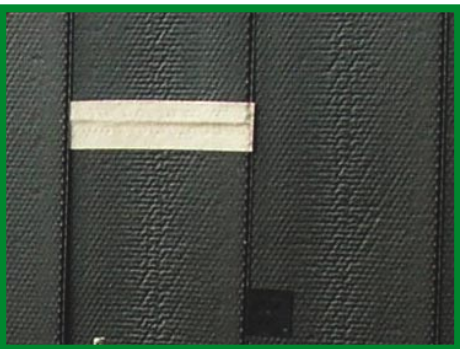
⑩ たて貼りカルドレーン端部切断部の不織布貼付け 2
