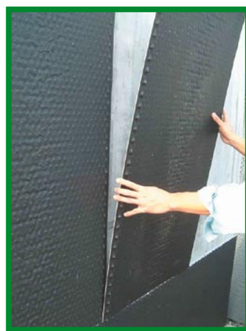
⑨ たて貼りカルドレーンの固定
