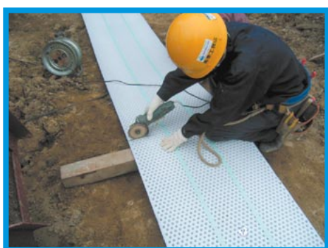
⑤ カルドレーンの切断
