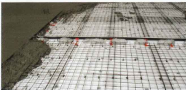
耐水性浮き床施工例
