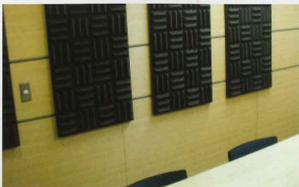
室内の残響調整簡易吸音パネル
