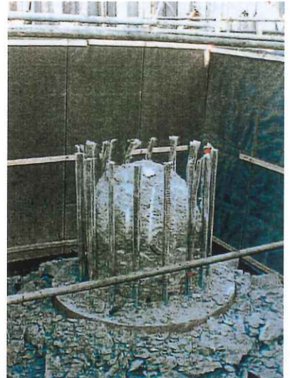
杭頭処理作業の防音対策
