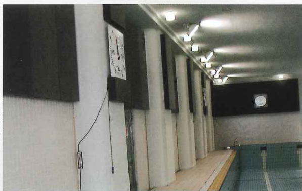
プールの吸音対策施工例
