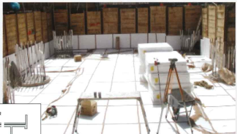
地下鉄からの固体音、振動対策施工例
