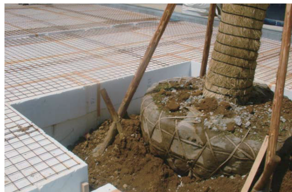
植栽周りの嵩上げにも対応でき、 屋上緑化などの軽量化が必要な場所に使用できます。
