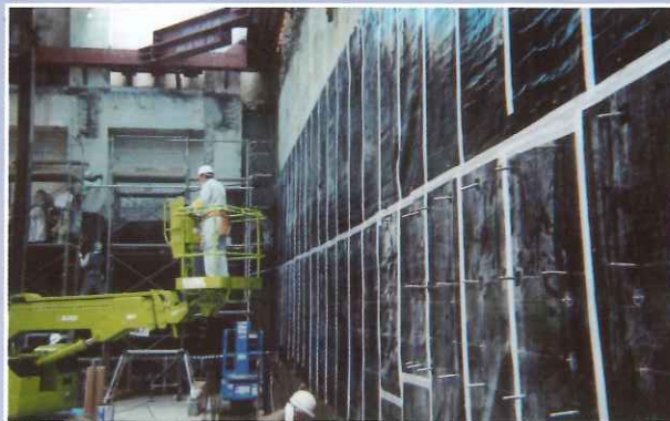
■ 下地：親杭横矢板 先付け施工例 ■
