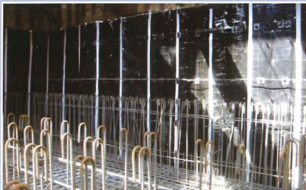
■ 下地：シートパイル 先付け施工例 ■
