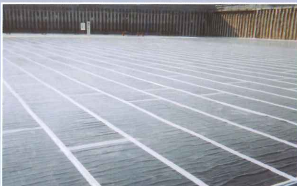
■ 下地：捨てコンクリート 後付け施工例 ■
