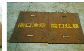
▲開口部の養生
