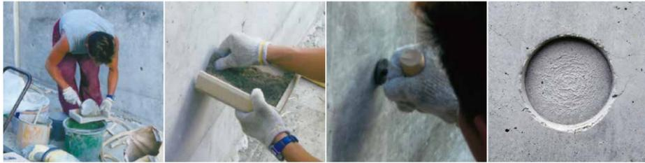
①モルタル練り混ぜ ②モルタル穴埋め ③モルタルコテ仕上げ ④仕上り
